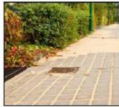
Pavé bétons avec joints sablés
