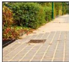
Pavé bétons avec joints sablés
