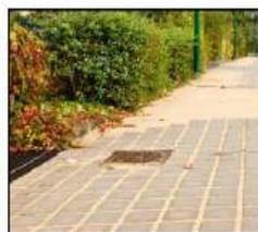
Pavé bétons avec joints sablés
