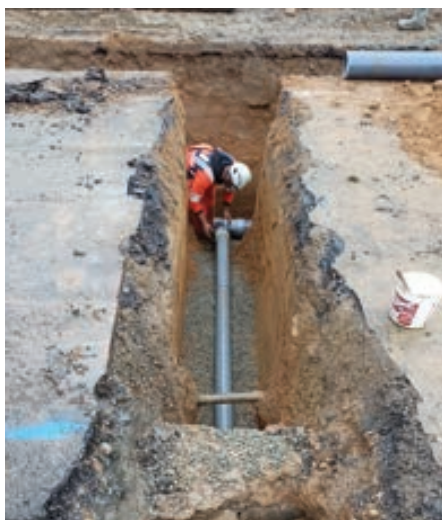
Travaux sur réseaux - Romagné
