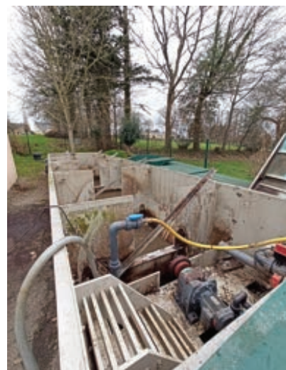
Travaux PR-La Chapelle-Janson
