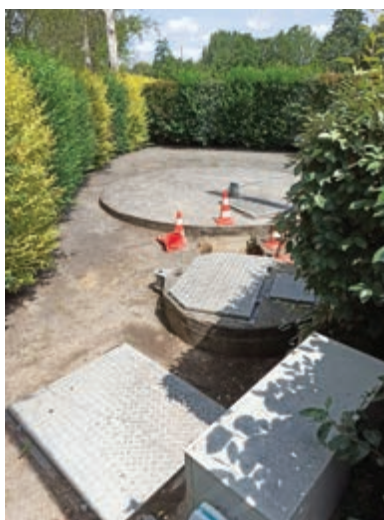
Travaux sur station - Le Ferré
